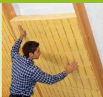
Den Hohlraum effektiv nutzen – der neue Klemmfalz Integra ZKF 1-032 bietet eine sehr gute Energieeffizienz bei begrenztem Raum. Er ist auf Grund seiner höheren Festigkeit auch bei großen Sparrenabständen sicher zu verlegen.
