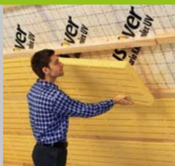
Mit 60 mm Dicke eignet sich der Integra UKF 1-032 ideal zur Untersparren-Dämmung für schlanke Dachkonstruktionen oder für mehrlagige Verlegung zwischen den Sparren. Hohe Energieeffizienz bei maximaler Wohnraumhöhe.
