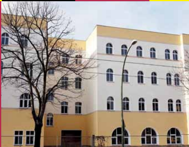
WDVS mit EPS-Dämmplatte und dickschichtigem, mineralischem Putzaufbau
