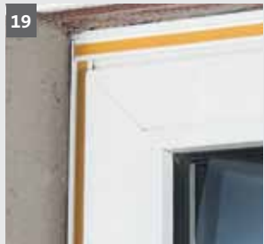
WDVS mit EPS-Dämmplatte und dickschichtigem, mineralischem Putzaufbau
