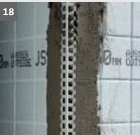
WDVS mit EPS-Dämmplatte und dickschichtigem, mineralischem Putzaufbau
