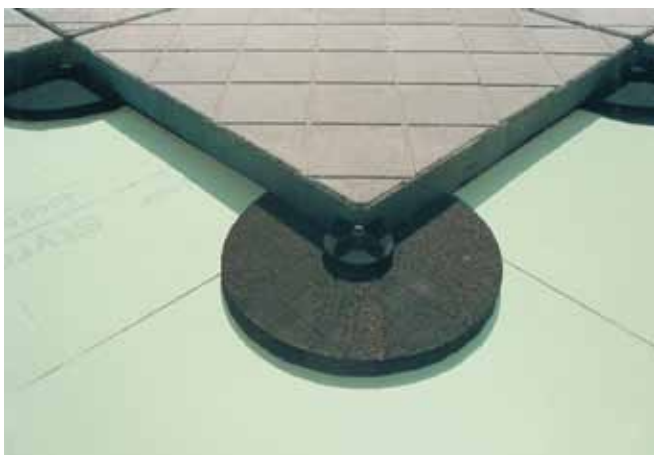
Abb. 74: Auf Styrodur® verlegte Betonplatten unter Verwendung von Aufstellersystem.
