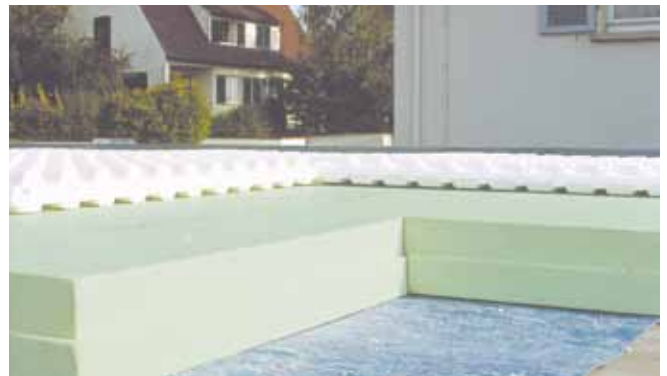
Abb. 52: Styropor®-Formteilplatten zur Wasserrückhaltung und Drainage eines begrünten Umkehrdaches mit Styrodur®.
