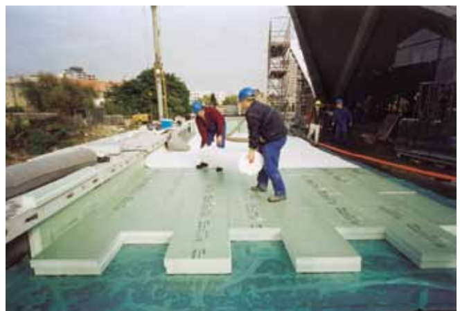
Abb. 45: Verlegung von Styrodur oberhalb der Dachabdichtung.
