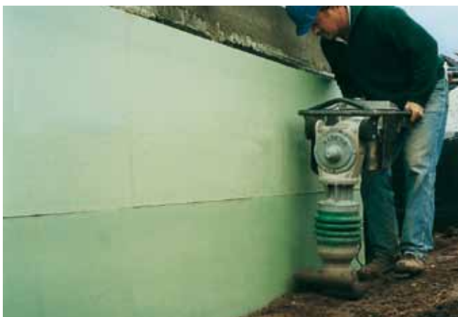
Abb. 28: Lagenweise Verfüllung der Baugrube und mechanische Verdichtung.
