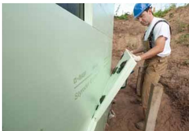
Abb. 5: Punktweise Verklebung der zweiten Lage Styrodur-Platten mit Stufenfalz und versetzten Fugen.
