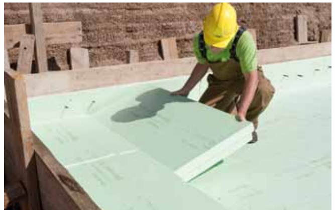
Abb. 8: Mehrlagige Verlegung von Styrodur®-Platten unter Bodenplatte nach DIBt Zulassung Z-23.34-1325.
