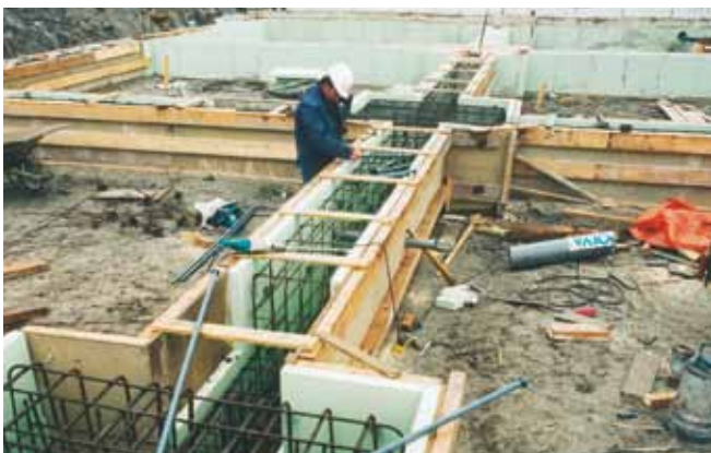
Abb. 25: Schalung mit Styrodur® C.
