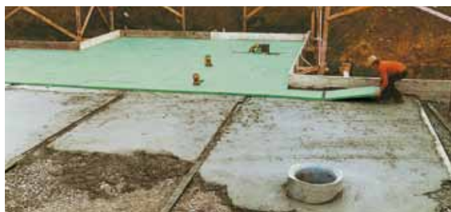
Abb. 6: Sauberkeitsschicht aus Magerbeton zur Verlegung der Bodendämmung.
