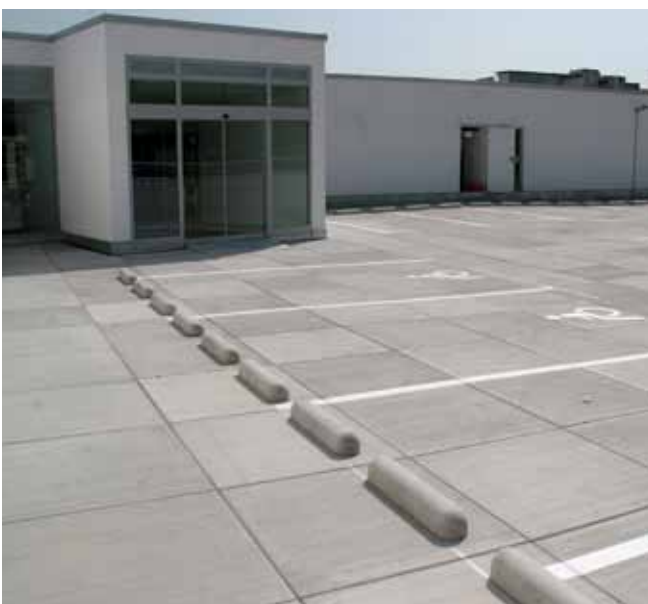
Abb. 81: Parkdach mit Fertigteilplatten (Quelle: Fa. BTE Stelcon GmbH.)
