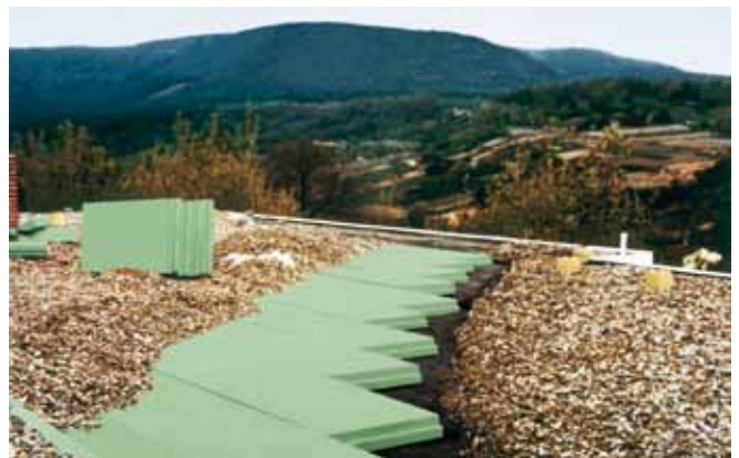
Abb. 47: Saniertes UK-Dach als Plusdachkonstruktion.
