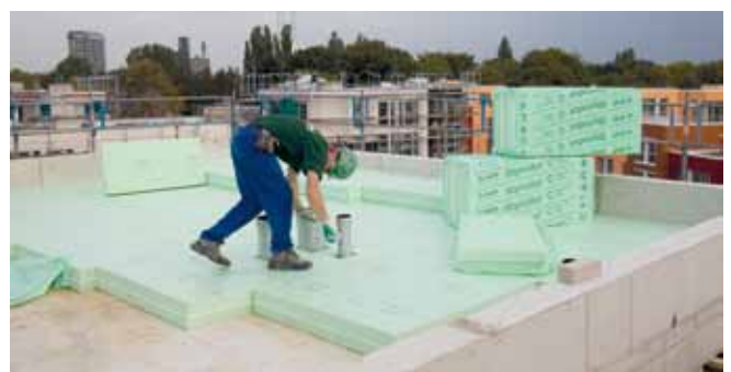
Abb. 33: UK-Dach-Dämmung mit Styrodur® von 250 Wohneinheiten in Hamburg.
