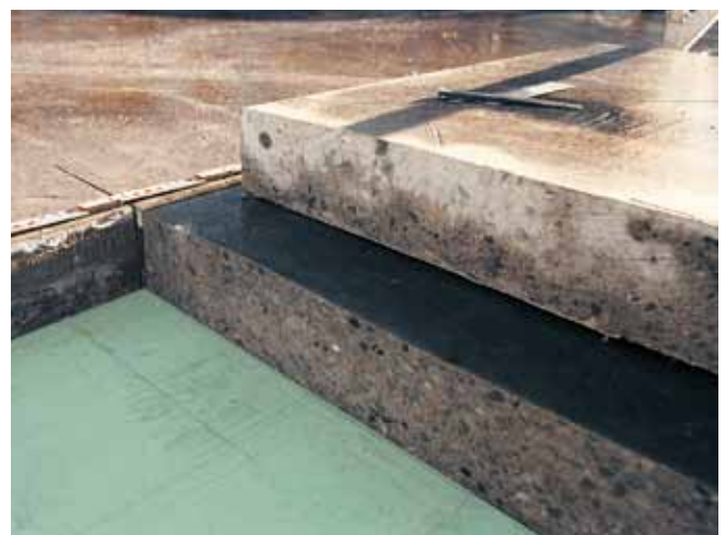
Abb. 82: Aufgeschnittene Ortbetonfahrbahnplatte zur wissenschaftlichen Untersuchung des Langzeitverhaltens.
