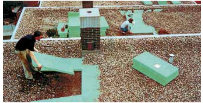
Abb. 31: Styrodur® ist aufgrund seiner Druckfestigkeit, geringen Wasseraufnahme und geringen Wärmeleitfähigkeit für UK-Dach-Konstruktionen hervorragend geeignet, z. B. bei Flachdachsanierungen als Plus-Dach.
