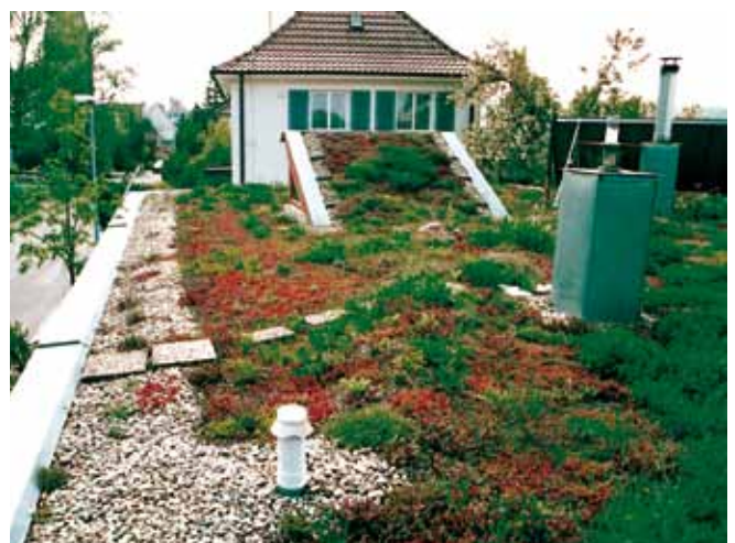
Abb. 66: Kiesstreifen am Dachrand und an Dachdurchdringungen.
