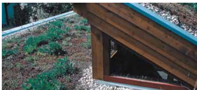
Abb. 57: Extensive Dachbegrünung mit trockenresistenten Pflanzen.
