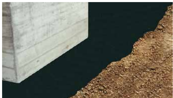
Abb. 15: Abdichtung der Kellerwand gegen drückendes Wasser.
