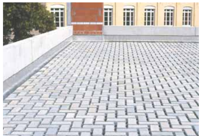
Abb. 79: Verlegtes Betonpflaster auf Styrodur®.
