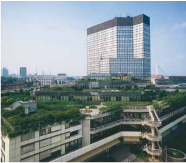
Abb. 58: Intensiv begrüntes Umkehrdach.
