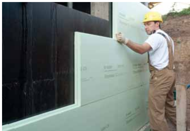
Abb. 4: Dichtgestoßene Styrodur®-Platten sorgen für eine wärmebrückenfreie Perimeterdämmung.
