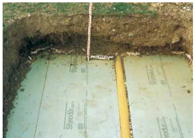
Abb. 36: Probeentnahme bei einem zehn Jahre alten, begrünten Umkehrdach.
