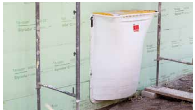
Abb. 22: Lichtschachtmontage bei Perimeterdämmung
