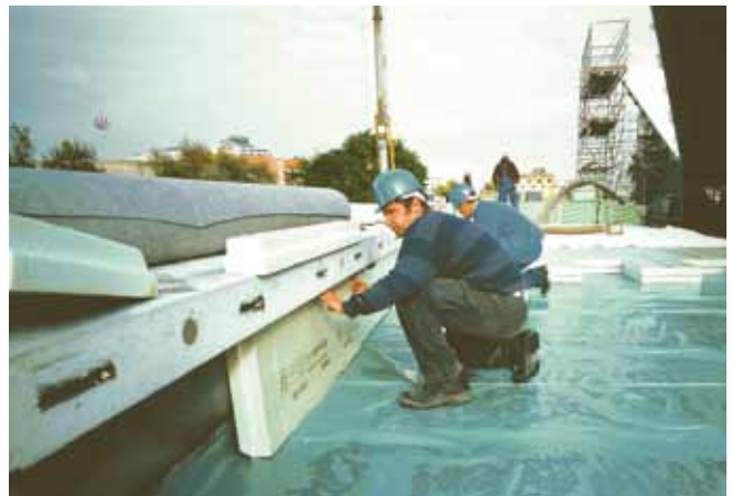
Abb. 44: Attika-Dämmung mit Styrodur.
