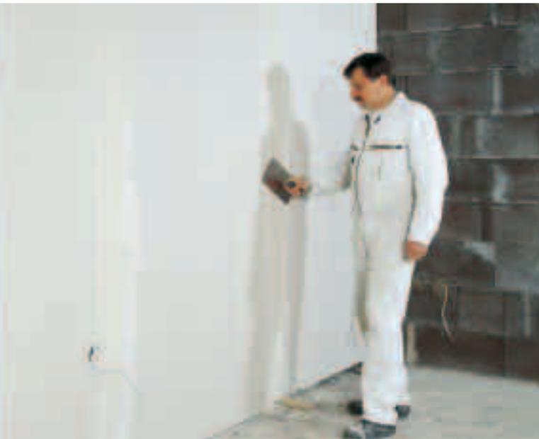
*Die Plattenstöße der Gipskarton-Verbundplatten sind einfach zu verfugen.*
