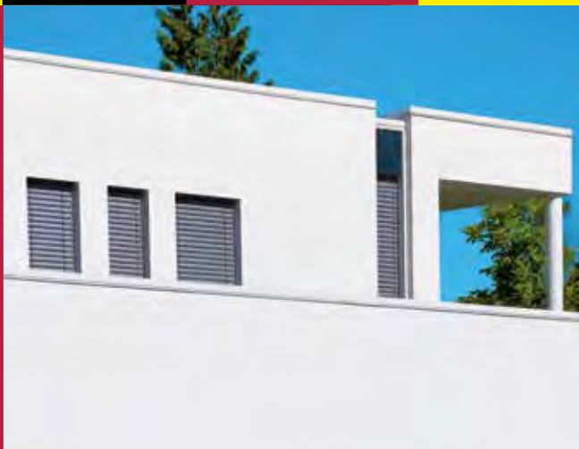
WDVS mit Hochleistungs-Dämmplatten aus Resol-Hartschaum und dickschichtigem Putzaufbau
