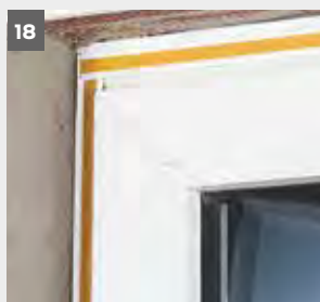
WDVS mit Hochleistungs-Dämmplatten aus Resol-Hartschaum und dickschichtigem Putzaufbau
