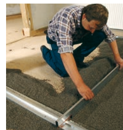
Abziehen der Rigidur Ausgleichsschüttung
