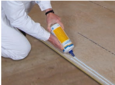
Auftragen des Rigidur Nature Line Estrichklebers auf den Stufenfalz
