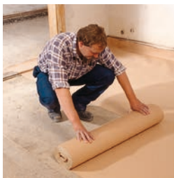
Ausrollen der Rieselschutzbahn
