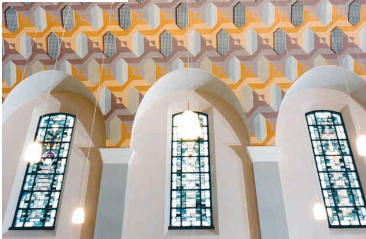
Die pinta PYRAMIDE ist ein hochwirksames Produkt zur Schallabsorption in ansprechendem Design. Durch die Struktur wird die Oberfläche vergrößert, und es werden gute Schallabsorptionswerte im mittleren bis hohen Frequenzbereich erzielt.
