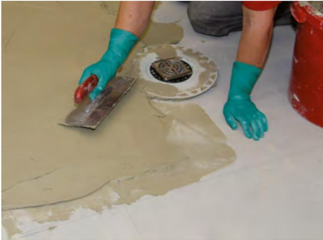
3 ... und das Gefälle bis zu einer Spachteldicke von 10 mm für die nachfolgende Verbundabdichtung vorbereiten.
