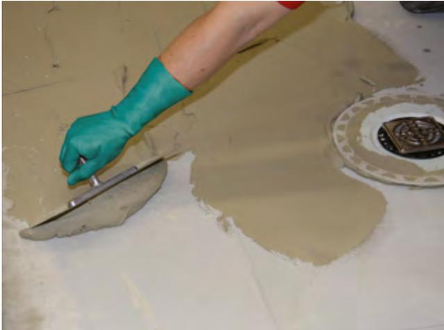
1 Für das Aufbringen einer partiellen Gefällespachtelung ist zuvor eine Kontaktschicht mit Sopro FKM XL aufzuziehen.
