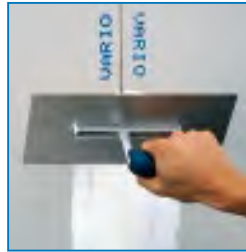
Spachteln ohne Rigips-Bewehrungsstreifen
