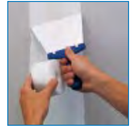
Spachteln mit Rigips-Bewehrungsstreifen
