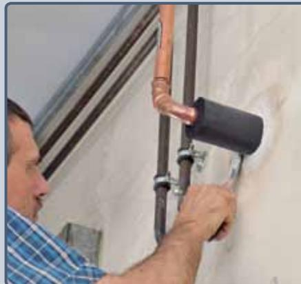
Armaprotect 1000 Brandschutzpaste direkt aus dem Eimer in die Durchführung einbringen, mit dem Spachtel oder von Hand den Ringspalt ausfüllen und anschließend die Oberfläche glattstreichen - fertig!
