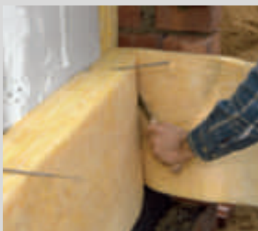
ISOVER Mineralwolle passt sich flexibel an Unebenheiten an und schützt durch gute Fugenverfilzung sicher vor Wärmebrücken.
