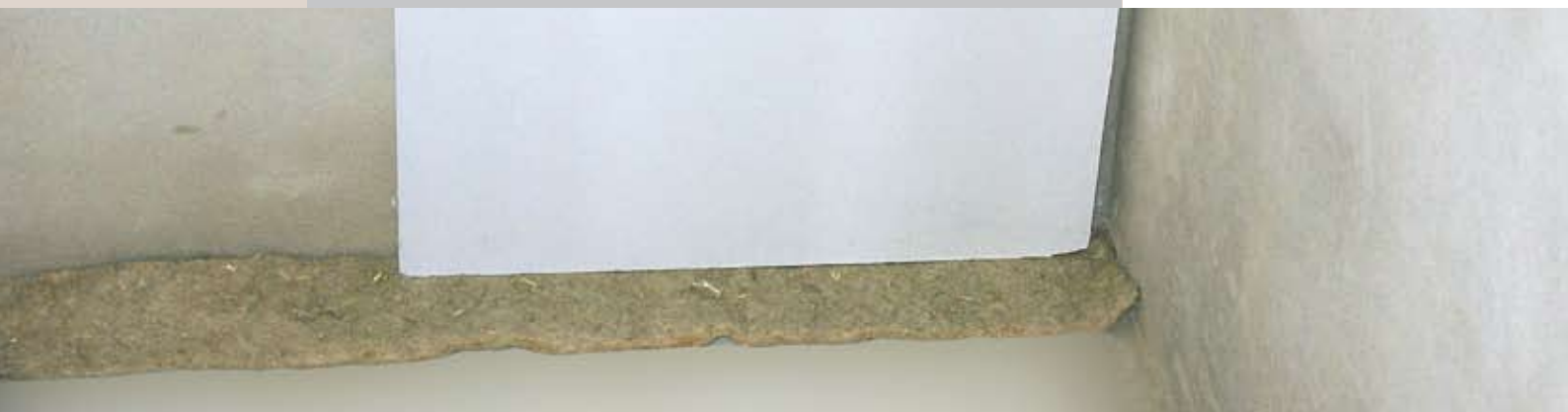
Ansetzen der Calsitherm Klimaplatte
