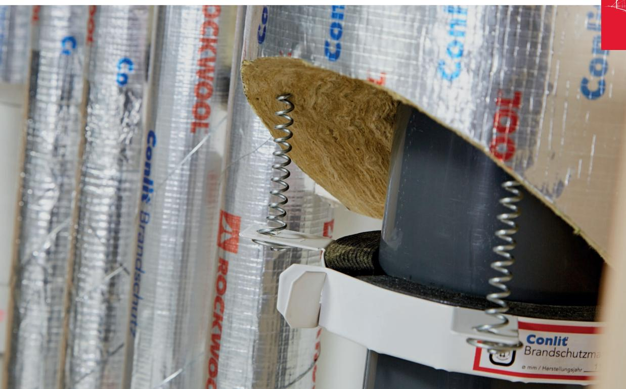
Spiralförmige Schraube aus verzinktem Stahl zur Verbindung von Steinwolledämmstoffen in Brandschutzkonstruktionen.
