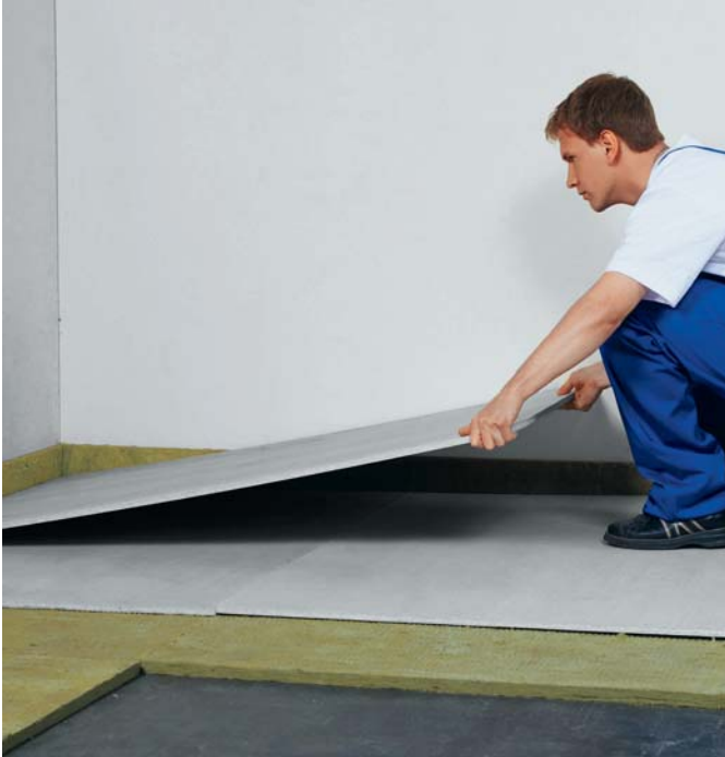
Fugenversetzte Verlegung von Gipsfaserplatten auf Rockwool Floorrock GP
