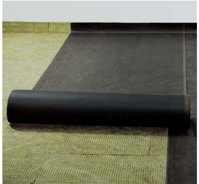
Abdeckung der Trittschalldämmplatten mit Bitumenpapier
