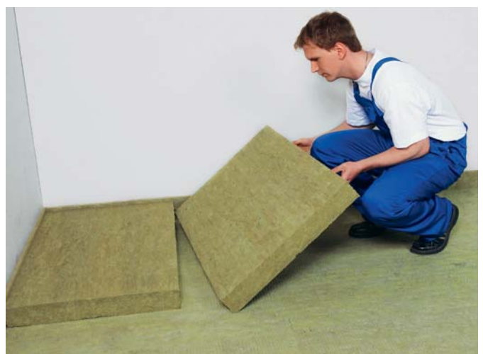
Zweilagige Verlegung durch Kombination von Floorrock SE mit Floorrock AP
