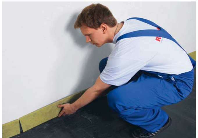
Rockwool Randstreifen RST verhindern Schallbrücken zu aufgehenden Bauteilen
