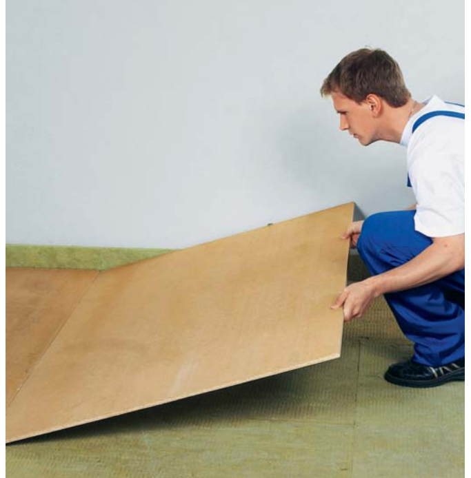
Schwimmend verlegte Holzspanplatten auf Rockwool Floorrock TE
