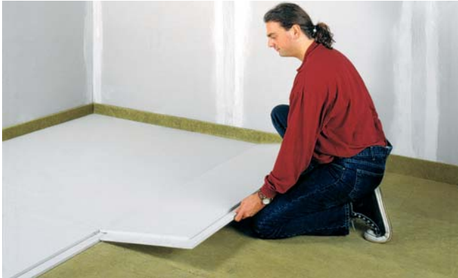
Verlegung eines Gipsfaser Estrich-Elements auf Floorrock GP
