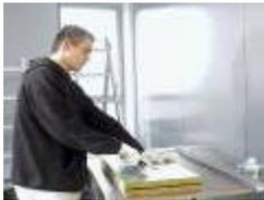
Messen Sie die Schotthöhe großzügig ab, damit diese zwischen Trennwand und der Rohbetondecke eingepasst werden können. Entweder werksseitiger Zuschnitt, oder aus Standardformaten mit einem Isoliermesser vor Ort.
