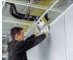
Stellen Sie die Unterseite des Schotts in das Bandraster oder T-Profil und kippen Sie das Schott in die entsprechende Position. Auch Ausschnitte sind völlig unproblematisch vor Ort mit einem Isoliermesser oder Cutter vorzunehmen.
