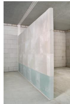
Randanschlussstreifen werden direkt nach dem Wandaufbau bzw. nach einer geforderten ganzflächigen Verspachtelung flächenbündig gekürzt.
