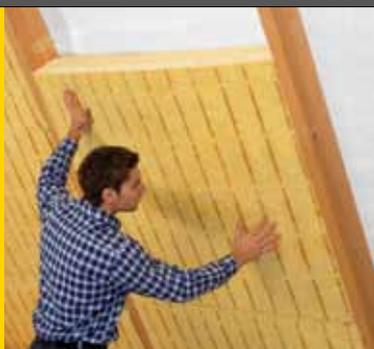
Den Hohlraum effektiv nutzen – der neue Klemmfilz Integra ZKF 1-032 bietet eine sehr gute Energieeffizienz bei begrenztem Raum. Er ist auf Grund seiner höheren Festigkeit auch bei großen Sparrenabständen sicher zu verlegen.
