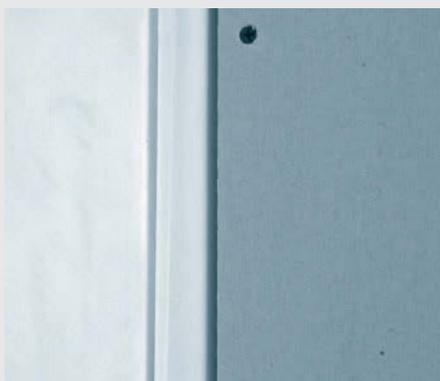
4. Knauf Platten mit 5 mm Abstand montieren
