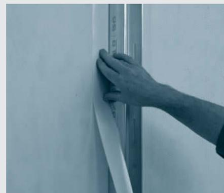
3. Alternativ Knauf Trenn-Fix auf anzuschließendes Bauteil kleben.
