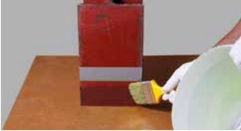
Vor Beginn der Abdichtungsarbeiten, Anschlussbereiche reinigen und mit PE-beschichtetem Abdeckband abkleben.
