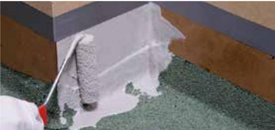
Nach einer Wartezeit von ca. 20 min Einbettschicht auftragen.
