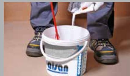
Katalysator (laut Mischtablelle, Temp. und Verarbeitungszeit) bei langsam laufendem Rührwerk zugeben und 2 Min. mischen. (Kleinmengen können auch von Hand gemischt werden)
