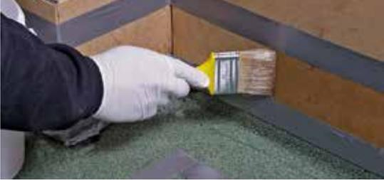
Vor Beginn der Abdichtungsarbeiten, Anschlussbereiche reinigen. Lose Schieferschuppen mittels Drahtbürste entfernen. Mit PE-beschichtetem Abdeckband abkleben. Abdeckband auch zur Entkopplung von Fugen oder heiklen Materialübergängen verwenden.
