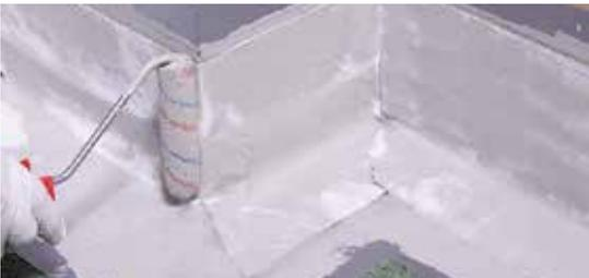
Das im Vorfeld zugeschnittene Vlies in die frische Einbettschicht einlegen und sofort mit der Rolle blasenfrei einarbeiten. Wenn beim Zurückklappen des Vlieses noch weiße Stellen vorhanden sind, wurde zu wenig Material vorgelegt.
