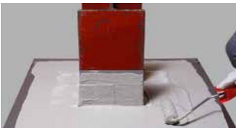
Ohne Wartezeit kann dann direkt das Vlies mit einer weiteren Schicht überdeckt werden.
