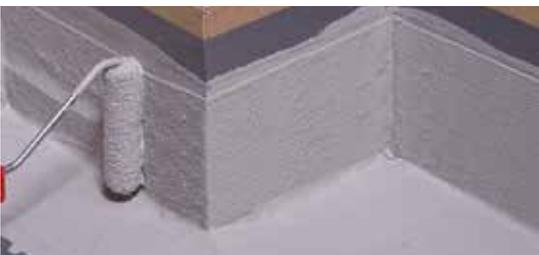
Ohne Wartezeit kann dann direkt das Vlies mit einer weiteren Schicht überdeckt werden.
