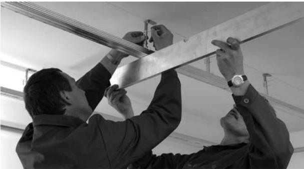
Ausfluchten der CD-Profile mittels Wasserwaage oder Lasergerät.
