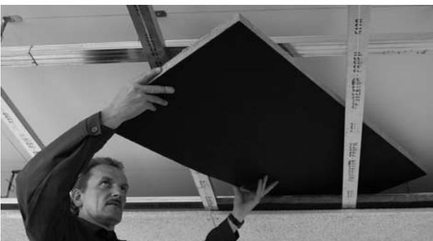
Einlegen von Heralan Absorberplatten, Zug um Zug mit der Montage der Heradesign Platten. Platten, die zwischen die Profile geklemmt werden, werden auf Maß geschnitten.
