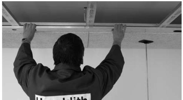
Ausfluchten der Plattenreihen mit Verlegelatte. Plattenstöße müssen mittig unter dem Profil angeordnet sein. Keine freien, schwebenden Plattenstöße zulässig!
