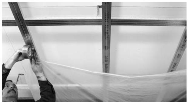
Alternativ: Einlegen einer PE-Folie als Rieselschutz oder Dampfbremse, Zug um Zug mit der Montage der Heradesign Platten. Folienstöße verkleben!
