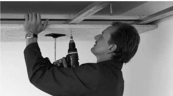
Montage der Platten mittels Hilfsstütze. Platte während des Schraubens mit dem Handballen an das Profil anpressen. Es darf kein Spalt zwischen Platte und Profil entstehen. Verarbeitung der Platten nur mit sauberen Händen und sauberem Werkzeug.
